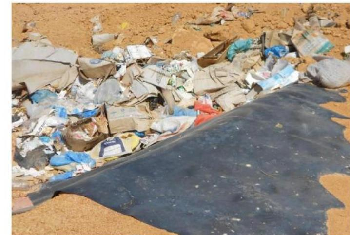
Detalhe da manta impermeabilizante no aterro sanitário MTR Madalena, que impede a passagem do chorume para o solo e subsolo.
